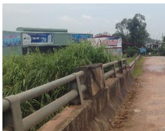
Khu vực cầu vượt quốc lộ 3
