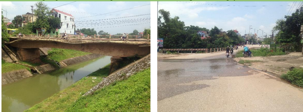
Hình 42: Hiện trạng giao thông tại khu vực cầu Đán
