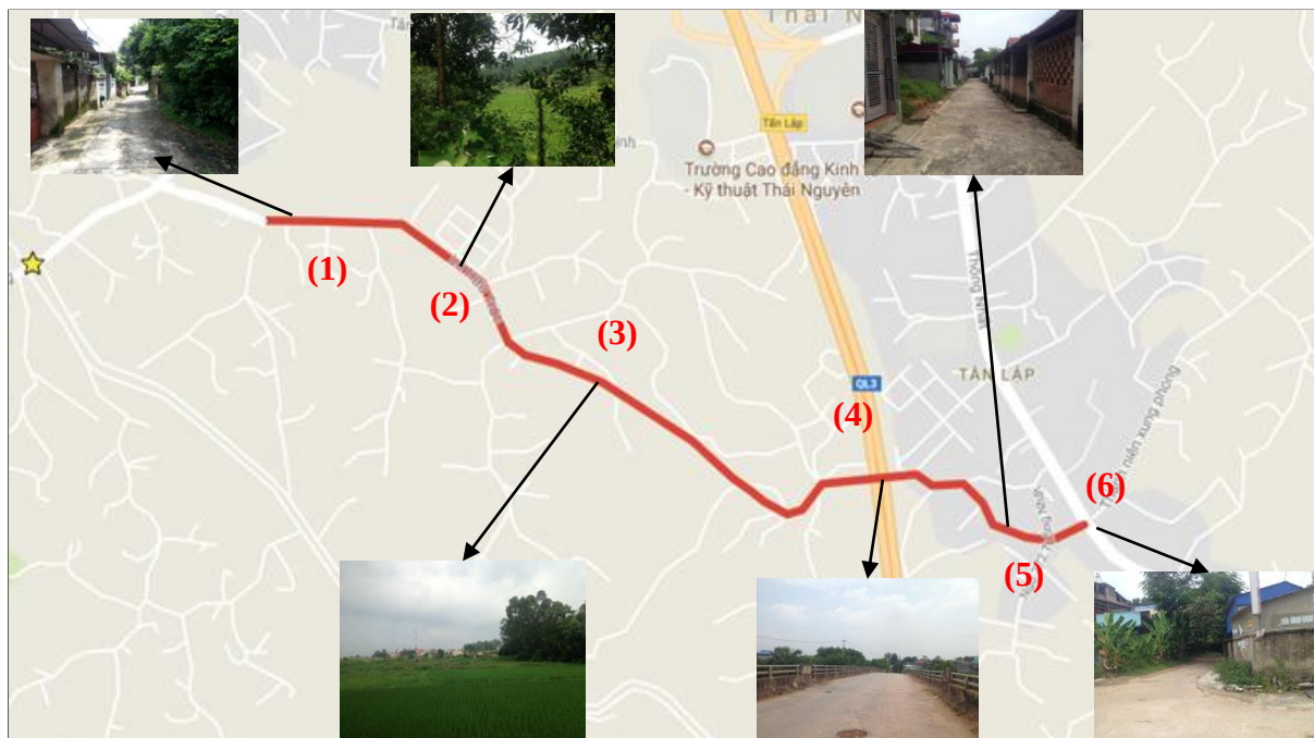
Hình 12: Hiện trạng đường Lê Hữu Trác
