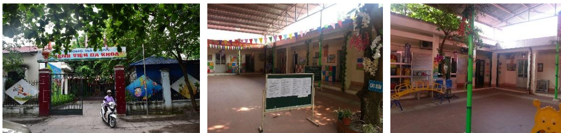
Hình 35: Hiện trạng cơ sở hạ tầng trường mầm non Phan Đình Phùng
