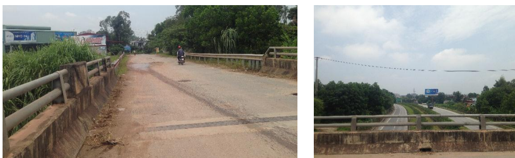
Hình 43: Hiện trạng giao thông tại khu vực cầu vượt quốc lộ 3
