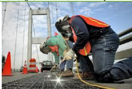
Hình 45: Hình ảnh tham khảo về hoạt động hàn khi xây dựng cầu
