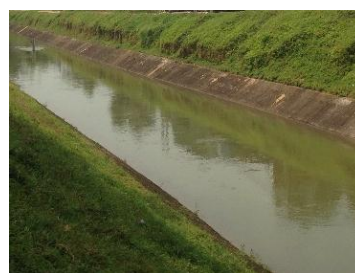
Kênh dẫn nước hồ núi Cốc (công trình 4)
