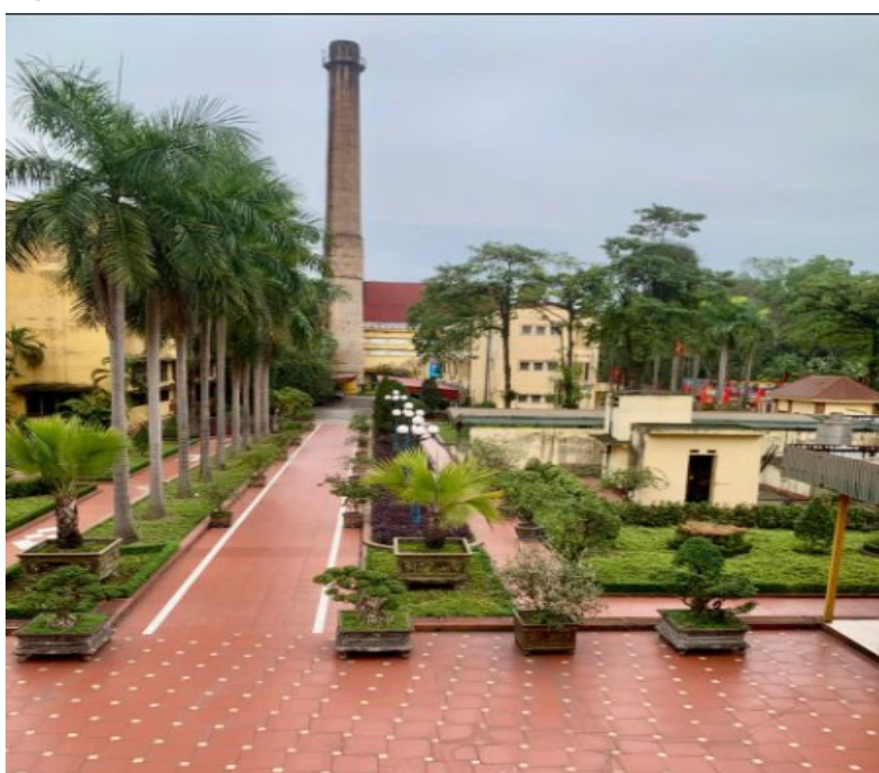
Hình 3.14. Hình ảnh ống khói khu vực lò nung
