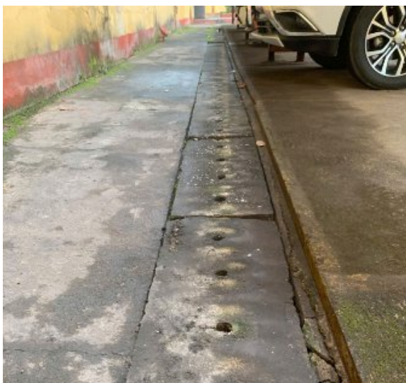
Hình 3.2. Hình ảnh thực tế hệ thống thu gom, thoát nước mưa của nhà máy
