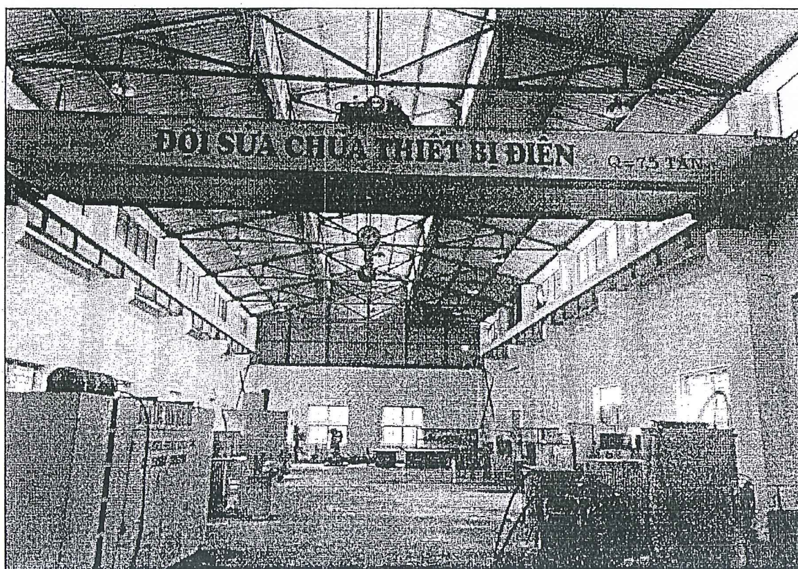
Hình 3. Hình ảnh tại Xưởng sửa chữa thiết bị điện
